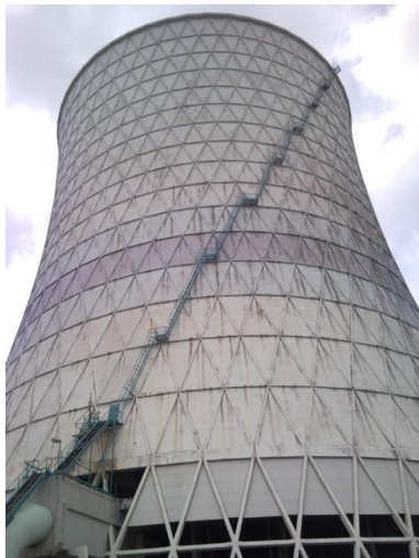
Armirano-betonska rebra hladilnega stolpa termoelektrarne Šoštanj
