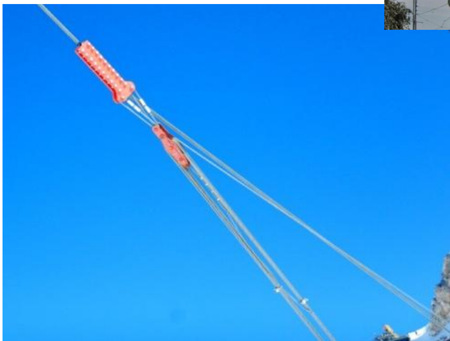
Primer: začasno napenjanje padle vrvi žičnice, Prevala, Kanin
